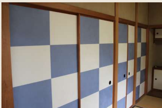
創作張り襖施工
